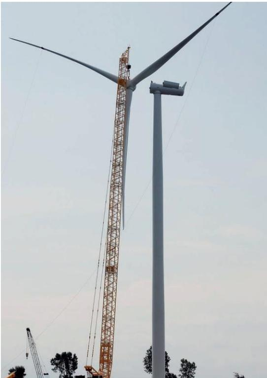
Figura 5.1-1 — Una gru Liebherr 1750 mentre solleva un gruppo rotore per l'installazione.
