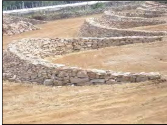
**Figura 5-4 Esempio muretto a secco per favorire condensazione acqua**
