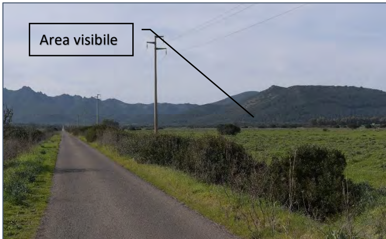
Figura 92 - Stato di fatto
