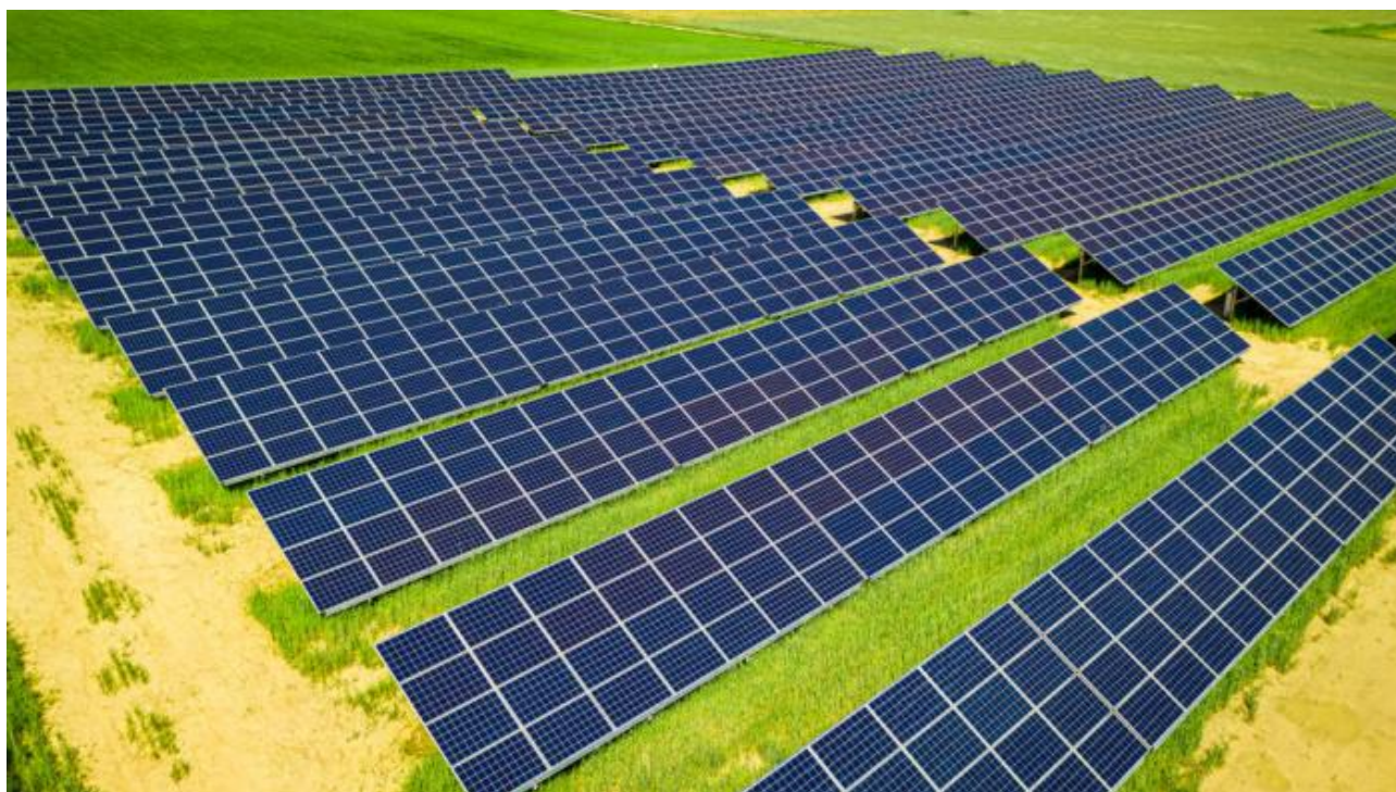
Figura 4 – strutture di sostegno fisse
