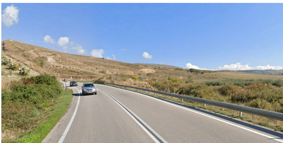
Figura 8 Cono 7 – Vista dalla SS 117bis (Ovest)
