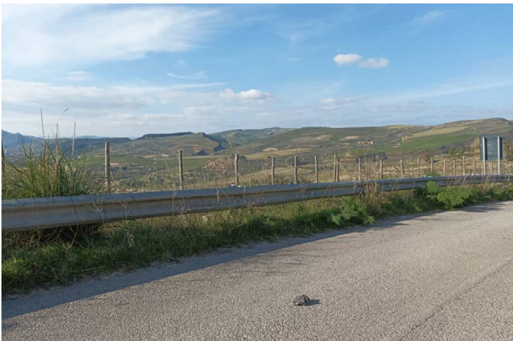
Figura 10 Cono 9 - Vista dalla SS 117bis (da Sud – Est)
