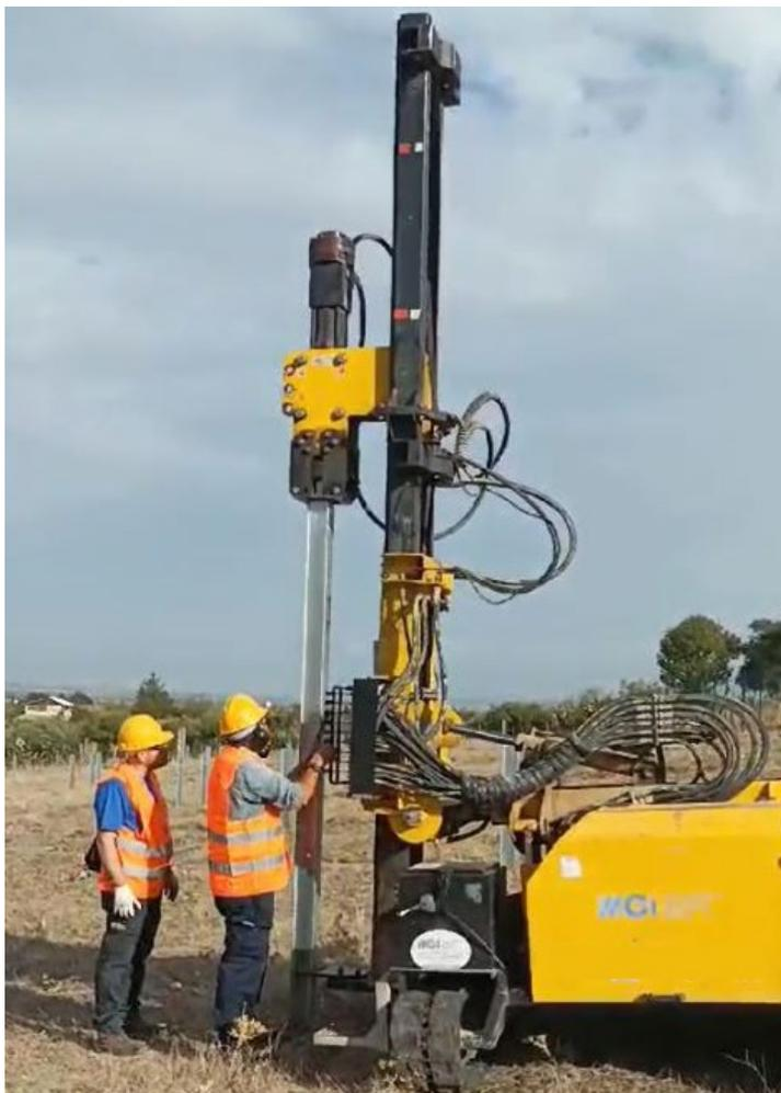
*Figura 7 - Esempio di installazione pali mediante battipalo*
