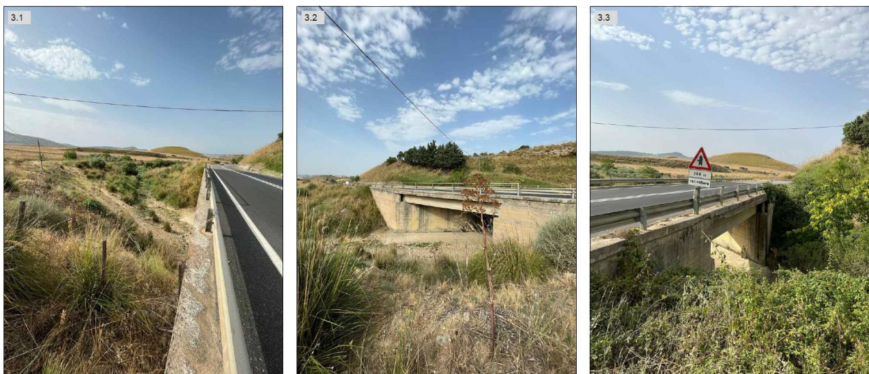
Figura 18 Attraversamento idraulico n.3 (Vallone dello stretto) – Foto
