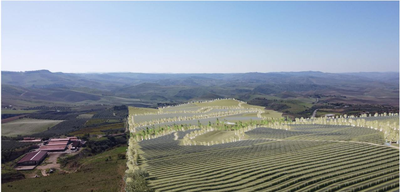
**Figura 5.29** Fotosimulazione vista da Nord-Ovest (scatto fotografico dal punto di vista PV01 della figura precedente). E' visibile la fascia arborea di mitigazione che cinge il perimetro dei diversi blocchi dell'impianto, per un'ampiezza di 10 m, (la visibilità dei moduli fotovoltaici è trascurabile).
