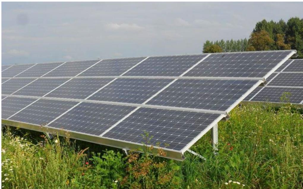
**Figura 4.6 Strutture Fisse.**
