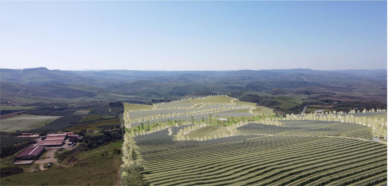
**Figura 25 - Fotosimulazione vista da Nord-Ovest (scatto fotografico dal punto di vista PV01 della figura precedente). E' visibile la fascia arborea di mitigazione che cinge il perimetro dei diversi blocchi dell'impianto, per un'ampiezza di 10 m, (la visibilità dei moduli fotovoltaici è trascurabile)**
