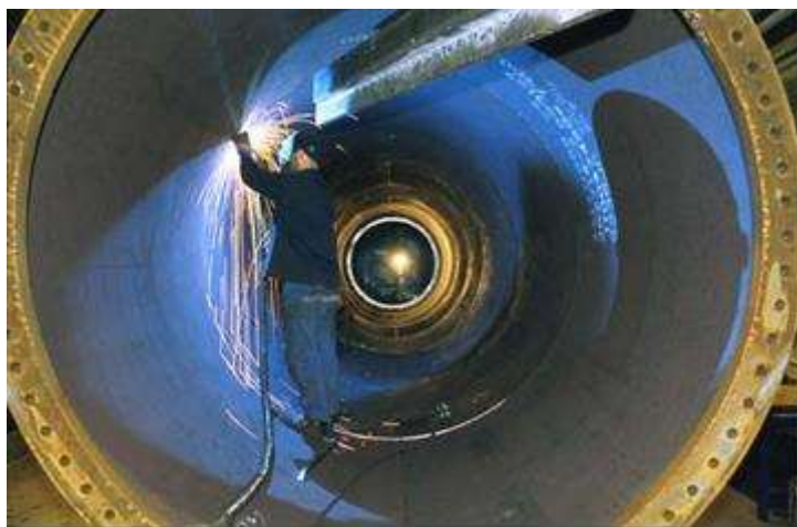
Figura 17: interno di una torre
