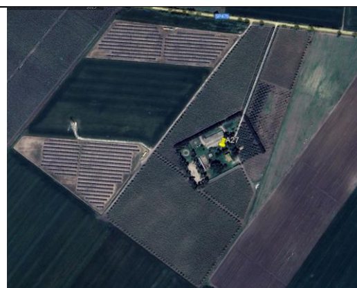
Masseria Piro e impianto FV esistente
