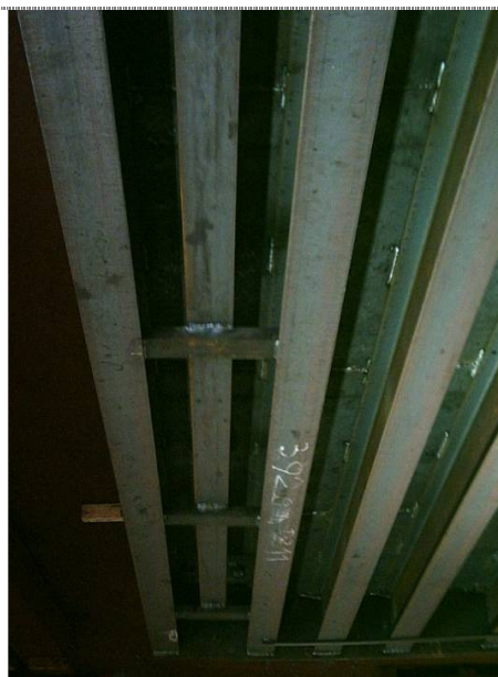
Particolare trave di rinforzo Foto 2
