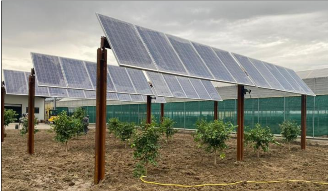
Figura 13 – Esempio strutture tracker utilizzate nell'impianto agrivoltaico
