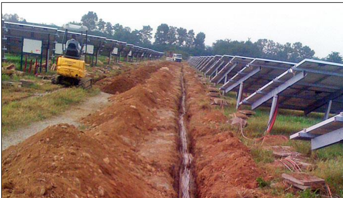
Figura 16 – Tipico di scavo per cavi BT/MT
