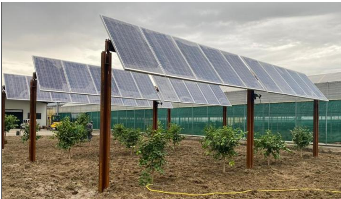
Figura 10 – Strutture di sostegno dei moduli "tracker"
