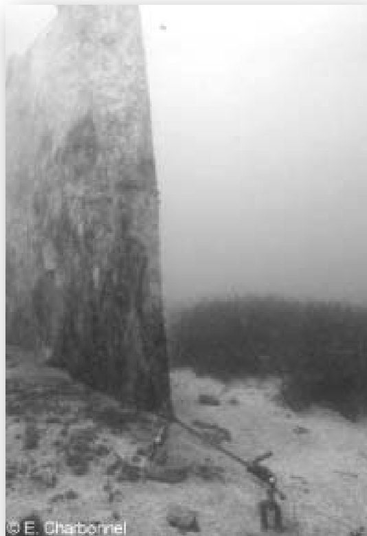
Figura 14 Uno schermo in geotessile (a sinistra) che protegge una prateria di Posidonia oceanica (a destra) in un lavoro sottomarino in Francia. (foto E. Charbonnel)
