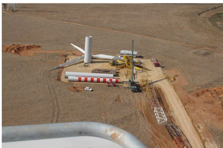
Figura 26 – Piazzola per il montaggio dell’aerogeneratore
