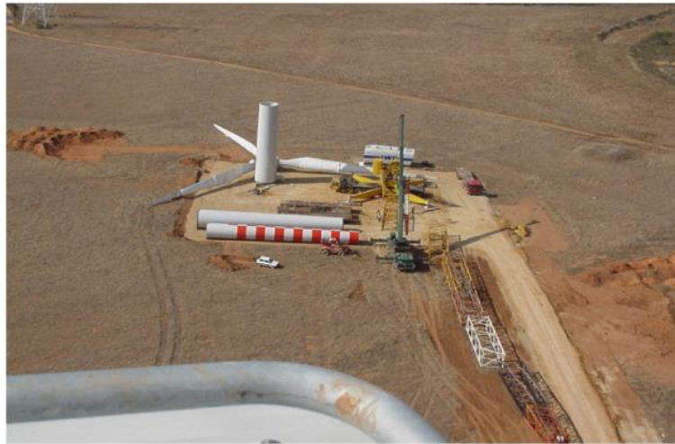
Figura 9 – Piazzola per il montaggio dell'aerogeneratore
