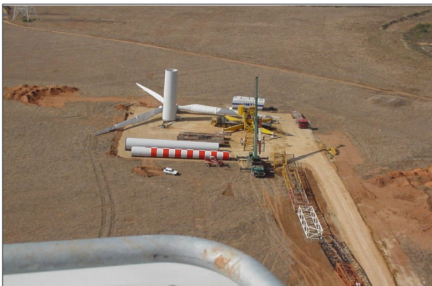
Foto 1. Piazzola per il montaggio dell'aerogeneratore
