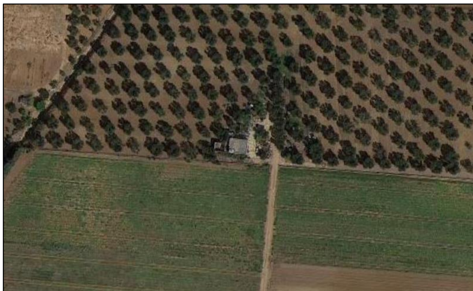
Figura 5 - Ortofoto Agea 2019 del fabbricato (punto 63)
