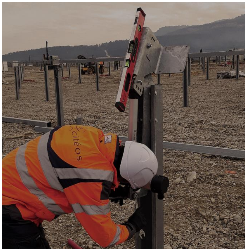
Figura 28 - Montaggio tracker
