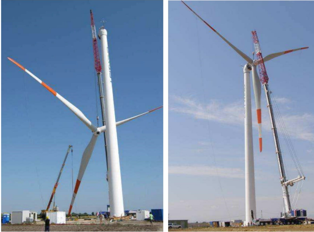
Foto 5 – Installazione pale
