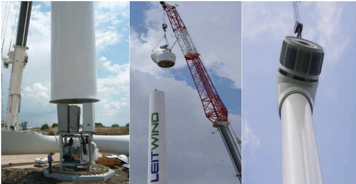
Foto 3 -Assemblaggio aerogeneratore
