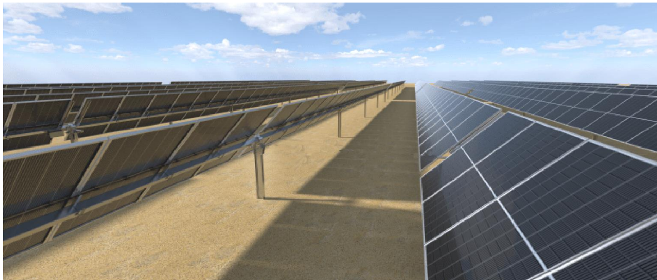
Figura 3.20: Esempio di filari unici di moduli su Tracker.
