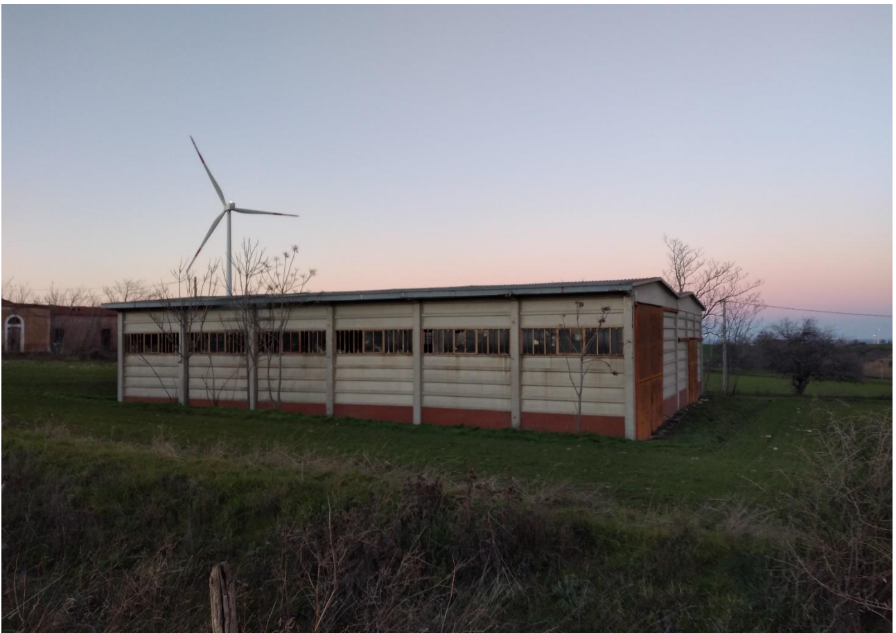
Fig. 3.7: Edifici esistenti lato Ovest su tratturo (Ovest)
