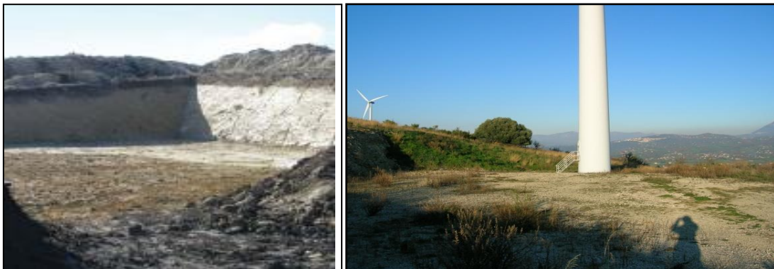
Figura 16: Piazzola temporanea di servizio ante e post operam
