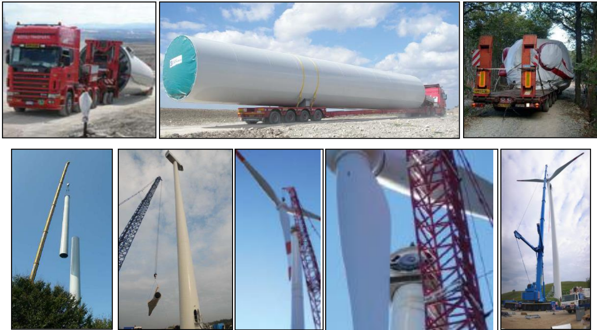
Figura 18: Trasporto e montaggio torri
