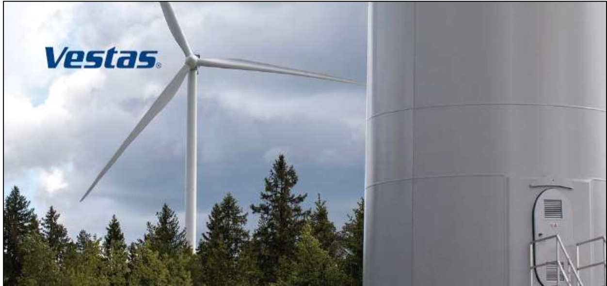
Figura 1: aerogeneratori Vestas immagine generica della tipologia di torre e rotore
