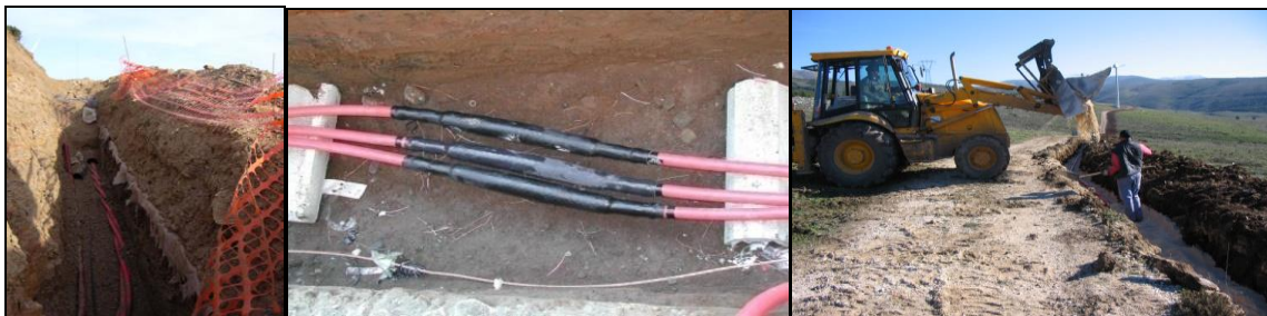
Figura 1: Posa cavi interrati
