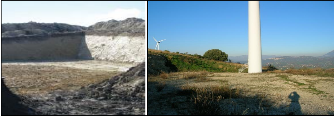
Piazzola temporanea di servizio ante e post operam
