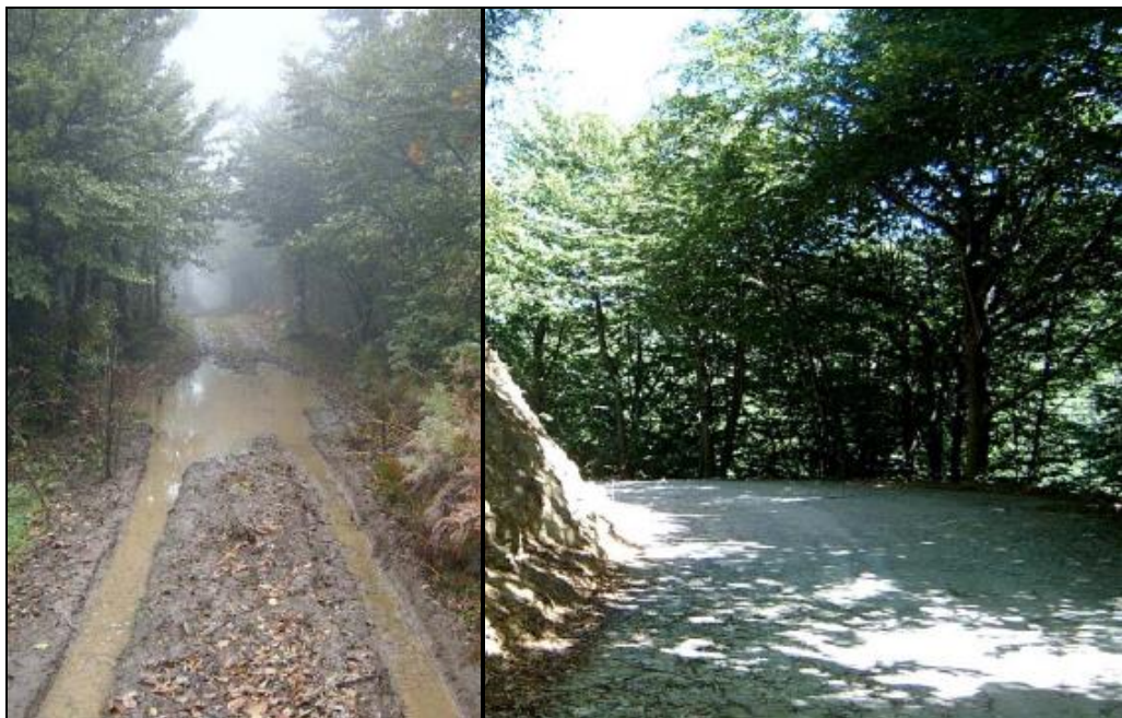
Strade di accesso prima e dopo i lavori di sistemazione
