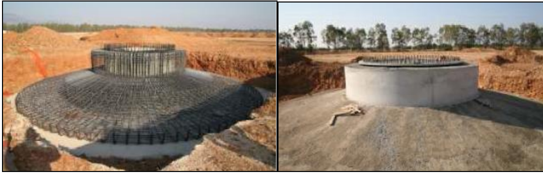
Fondazione aerogeneratore con pali
