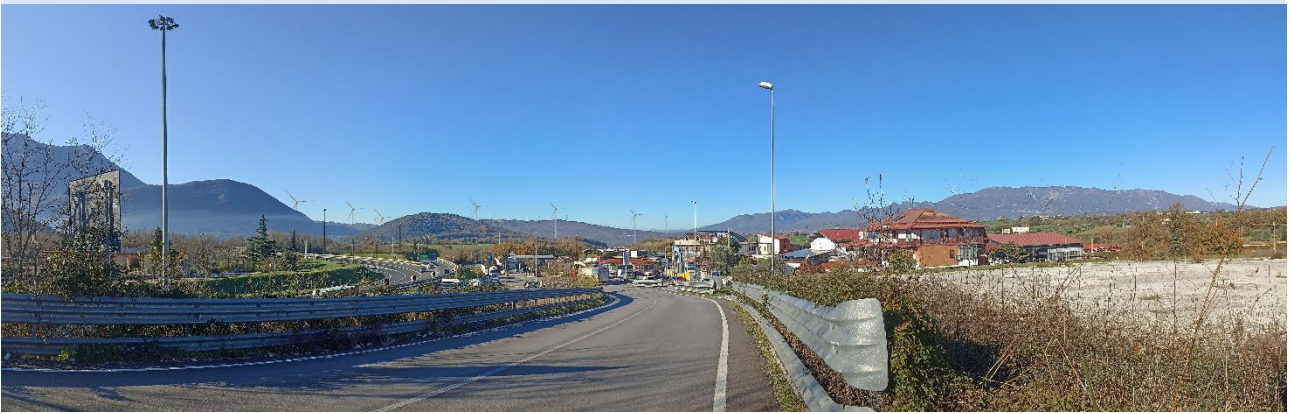
PUNTO 4 – Sicignano (SA) Area di Servizio - Post Operam
