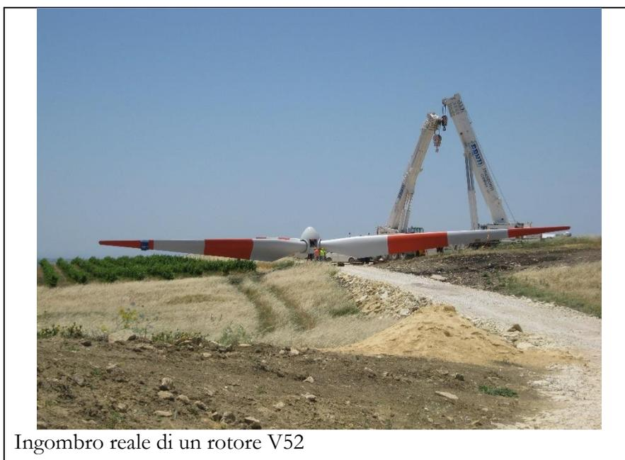
Ingombro reale di un rotore V52
