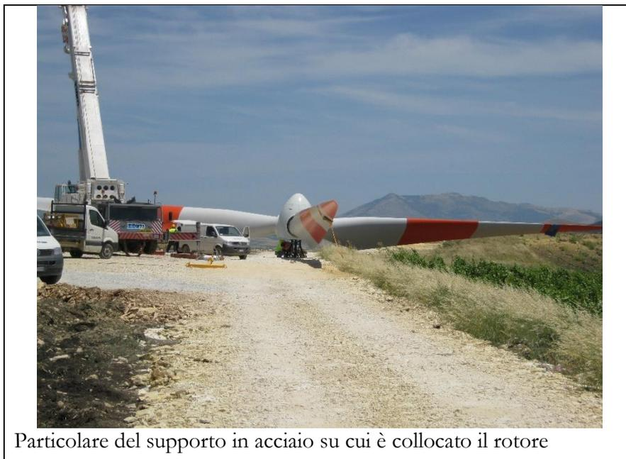
Per lo smontaggio della navicella e delle porzioni di traliccio in acciaio può essere impiegata la medesima area di dimensioni 12 m x 12 m utilizzata per lo smontaggio del rotore. In particolare, per lo smontaggio delle porzioni di traliccio sarà previsto il supporto di almeno due operatori su cestello elevatore che provvederanno ad allentare i bulloni che connettono una porzione di traliccio all'altra.
