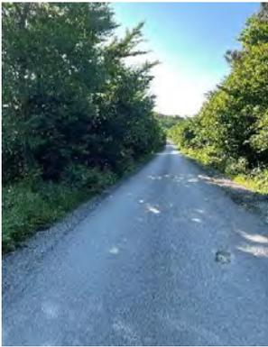
Si prosegue, quindi, dal km. 12,065 al km. 13,208 (**vedi UR 17**) (foto 73-76). Il progetto prevede l'inserimento del cavidotto per km. 1,143 lungo la strada asfaltata che conduce alla Ex Base Nato seguendo il crinale di Pian dei Corsi, dove a quota 1007 m. s.l.m. è prevista la messa in opera di un areogeneratore F01 mediante la creazione di una piazzola di forma rettangolare (25.0 m. X 60.0 m) in una zona di cresta.
