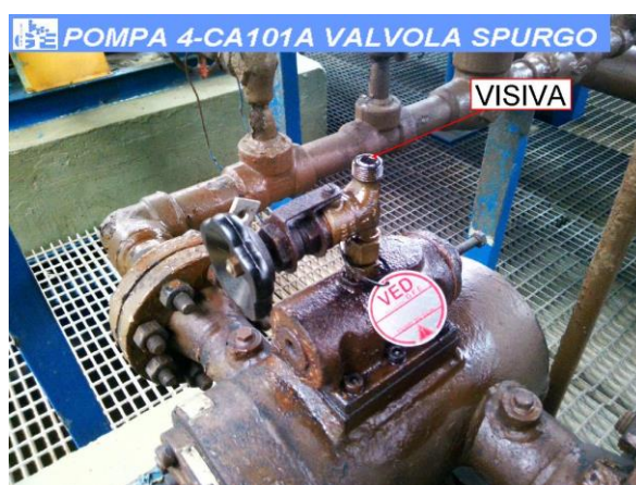
Foto del componente in perdita
