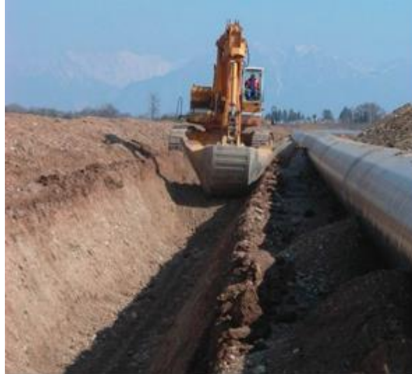
Fig. 2-3 - Scavo per l'alloggiamento della condotta
