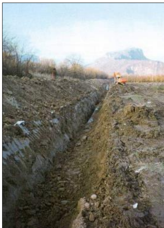
Fig. 2-5 - Operazione di rinterro della condotta
