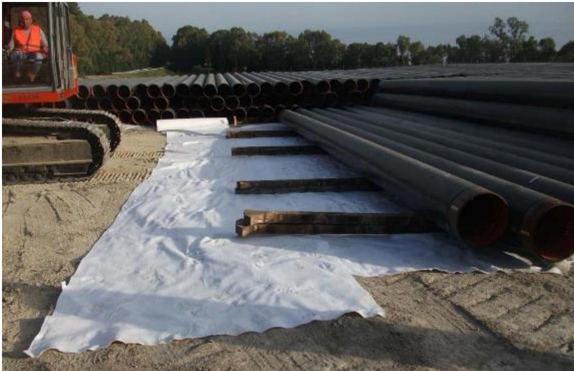
Fig. 2-1 - Piazzola di accatastamento tubazioni
