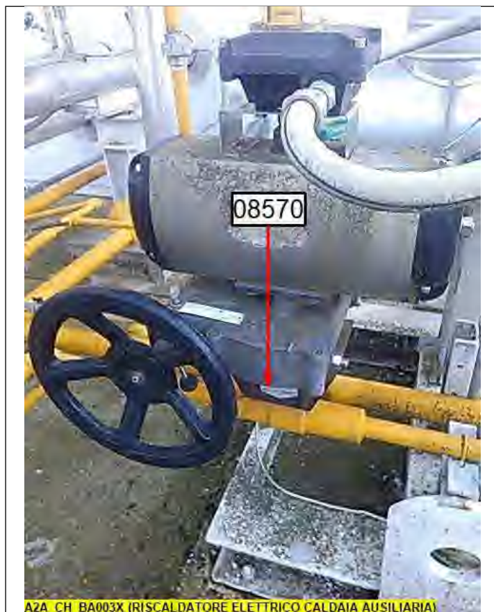
A2A_CH_BA003X (RISCALDATORE ELETTRICO CALDAIA AUSILIARIA)
