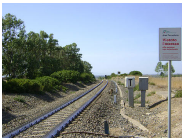
Figura 2 - Vista lato Solarussa Km 107+885 – Curva R=1000 m.
