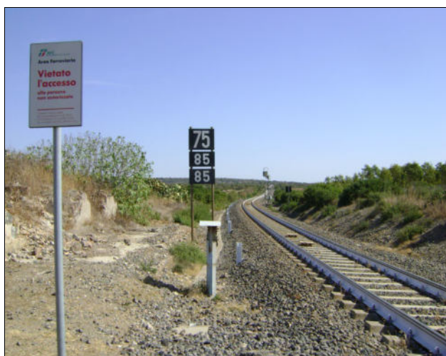
Figura 4 - Vista lato Bauladu Milis Km 107+885 – Curva R=1000 m.
