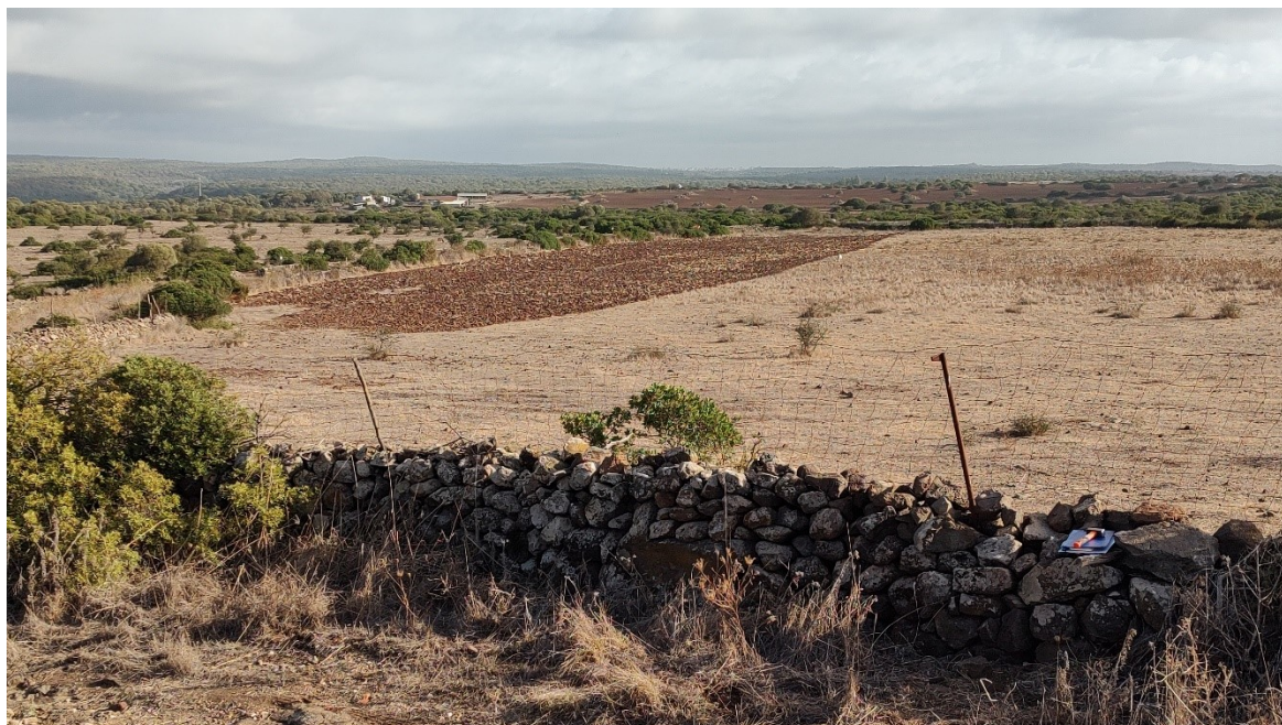
Foto 20 – Vista panoramica del settore di imbocco nord della galleria naturale.
