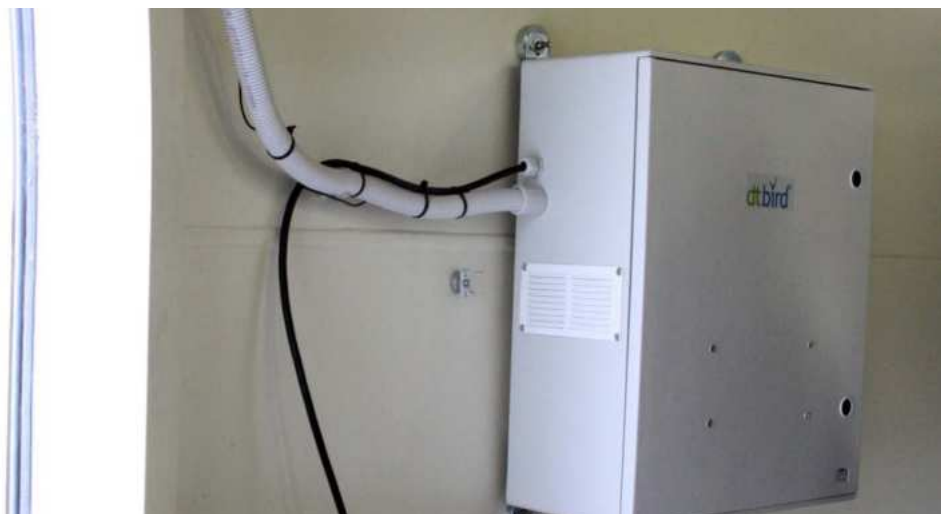
Figur 13. DTBirds datacentral har formen av en låda som monteras på vindkraftverkets innervägg. Foto: Therese Säfström.
