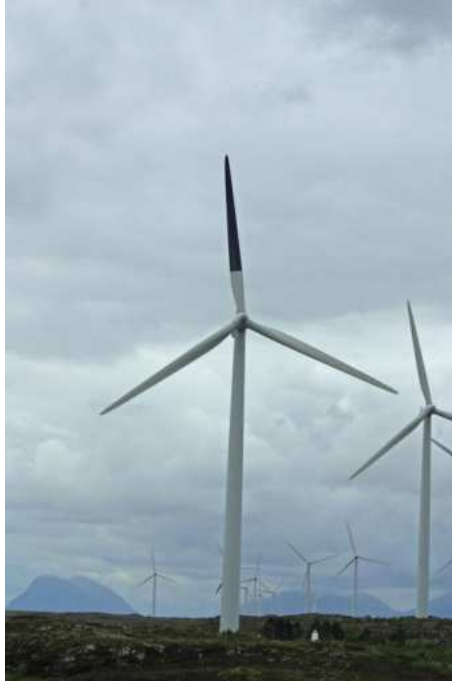
Figura 14. Esempio di turbina eolica con pala colorata. Fonte: May et al., “Paint it black: Efficacy of increased wind turbine rotor blade visibility to reduce avian fatalities”
