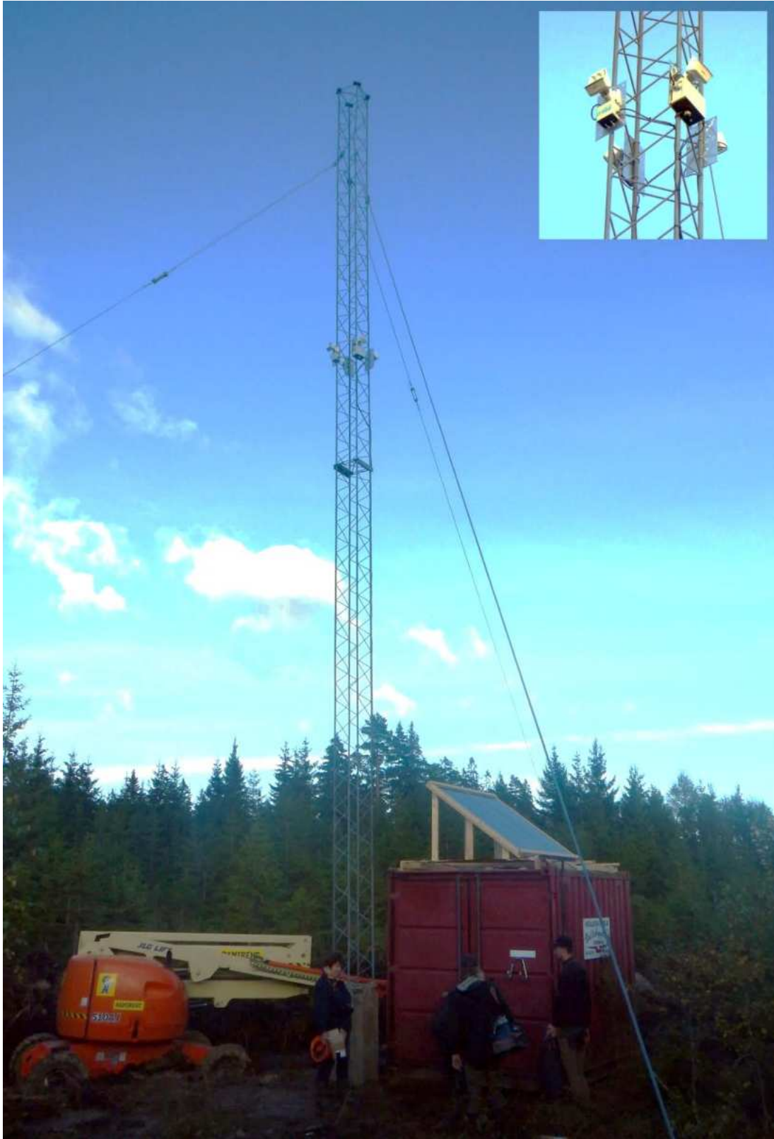
Figur 14. Installation av DTBirds detektionsmodul i en vindmättningsmast på Billingen mellan Skara och Skövde i syfte att övervaka flyttningen av tranor över ett tilltänt vindprojekteringsområde. En container användes för att montera detektionsmodulen. Internetuppkoppling för kontakt med webbplattform åstadkoms med ett mobilt bredband. Elförsörjning löstes genom användande av solpanel. Täckningen på det mobila bredbandet fungerade inte hela tiden, men då det monterade DTBird-systemet lagrade all data lokalt, överfördes data kontinuerligt när systemet kom online. Som helhet fungerade undersökningen mycket bra. Infällt uppe till höger syns inzoomad bild på monterade kameror.
