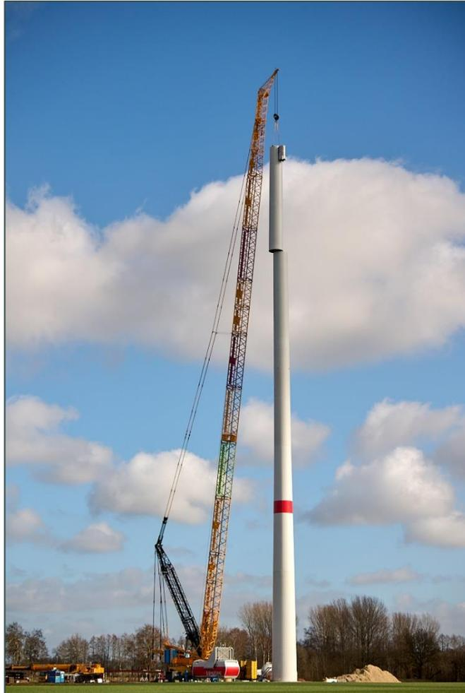
**Abbildung 1 - Errichtung des Turms der WEA 7 im Windpark Bakum
