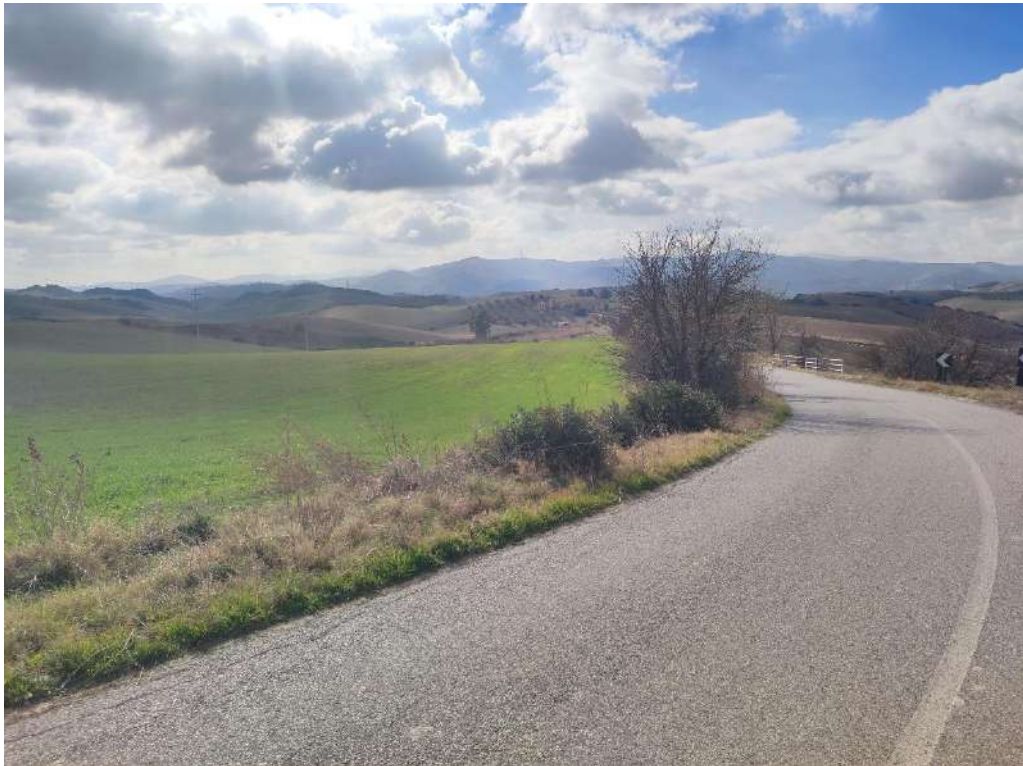
Fig. 63 Punto di presa n. 2: Stato di Fatto (Stazione Terna SpA).
