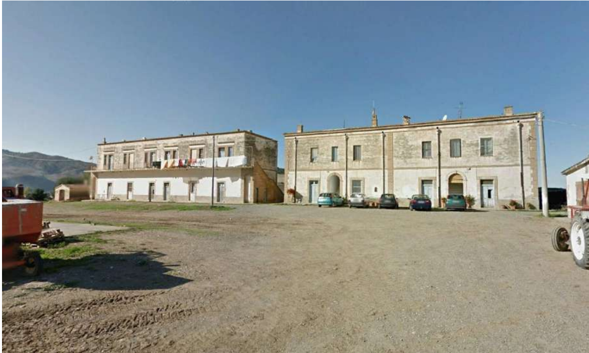
Fig. 71 Punto di presa n. 1: Stato di Fatto (Masseria Gannano di sotto).
