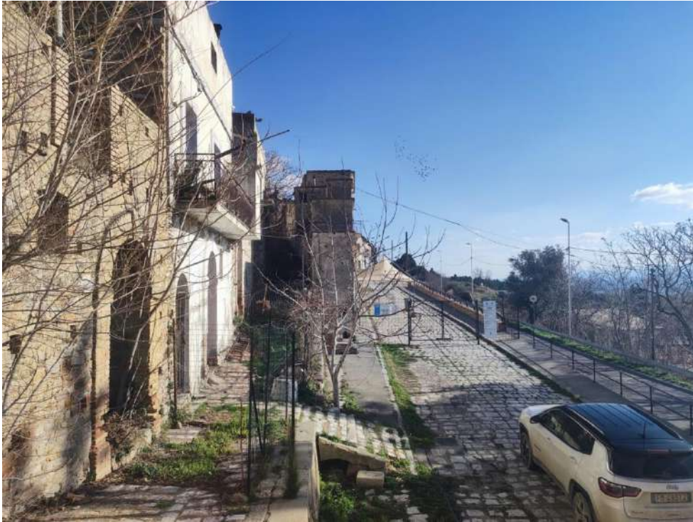
Fig. 43 Punto di presa n. 10.2: Stato di Fatto (Centro storico Craco).
