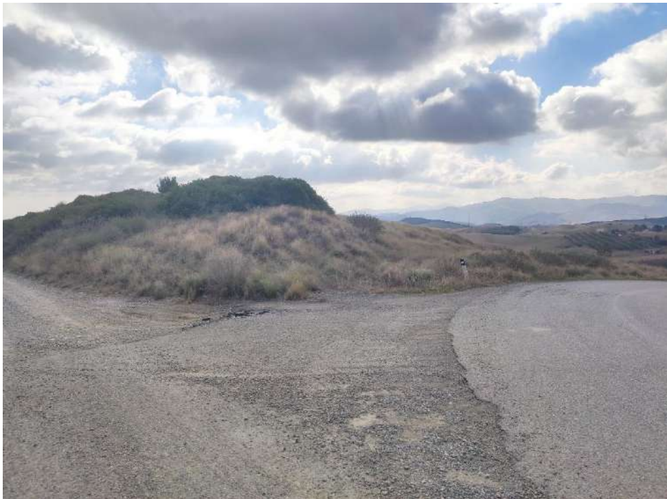
Fig. 59 Punto di presa n. 1: Stato di Fatto (Stazione Terna SpA).
