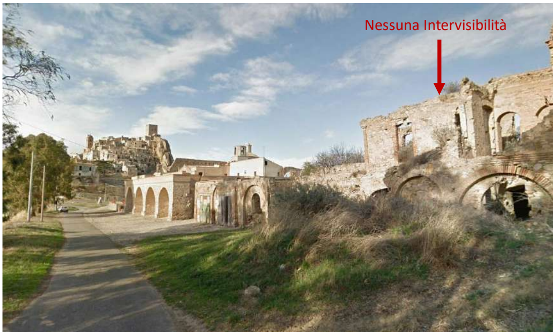
Fig. 80 Punto di presa n. 3: Stato di Progetto (Ex Monastero Francescani con Chiesa San Pietro)
