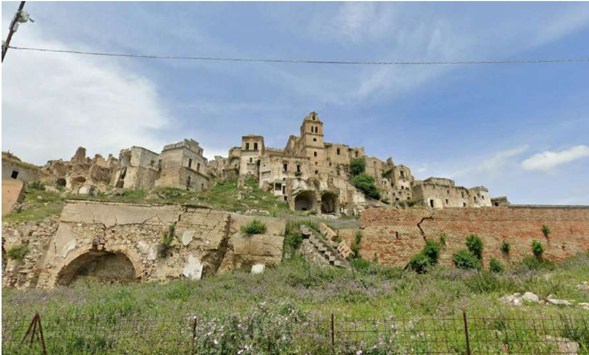
Fig. 83 Punto di presa n. 4: Stato di Fatto (Torre Normanna - Craco vecchia).
