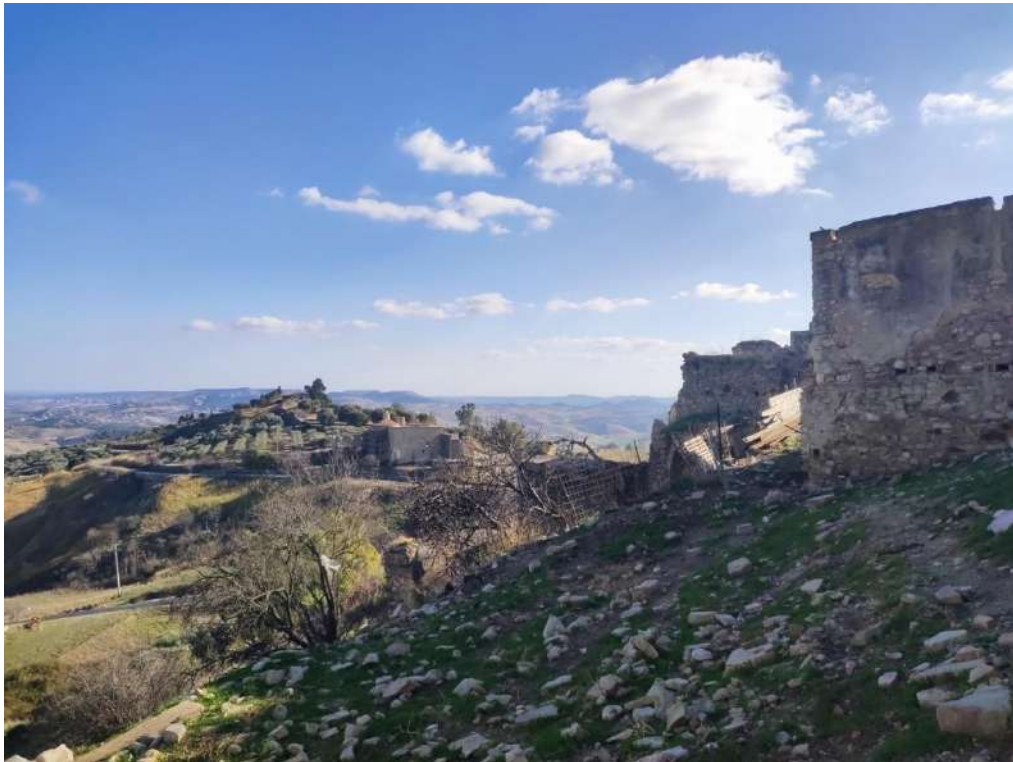
Fig. 34 Punto di presa n. 9: Stato di Fatto (Centro storico Craco).
