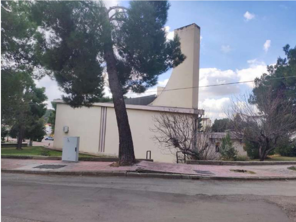
Fig. 30 Punto di presa n. 8: Stato di Fatto (Centro abitato Craco – Peschiera).
