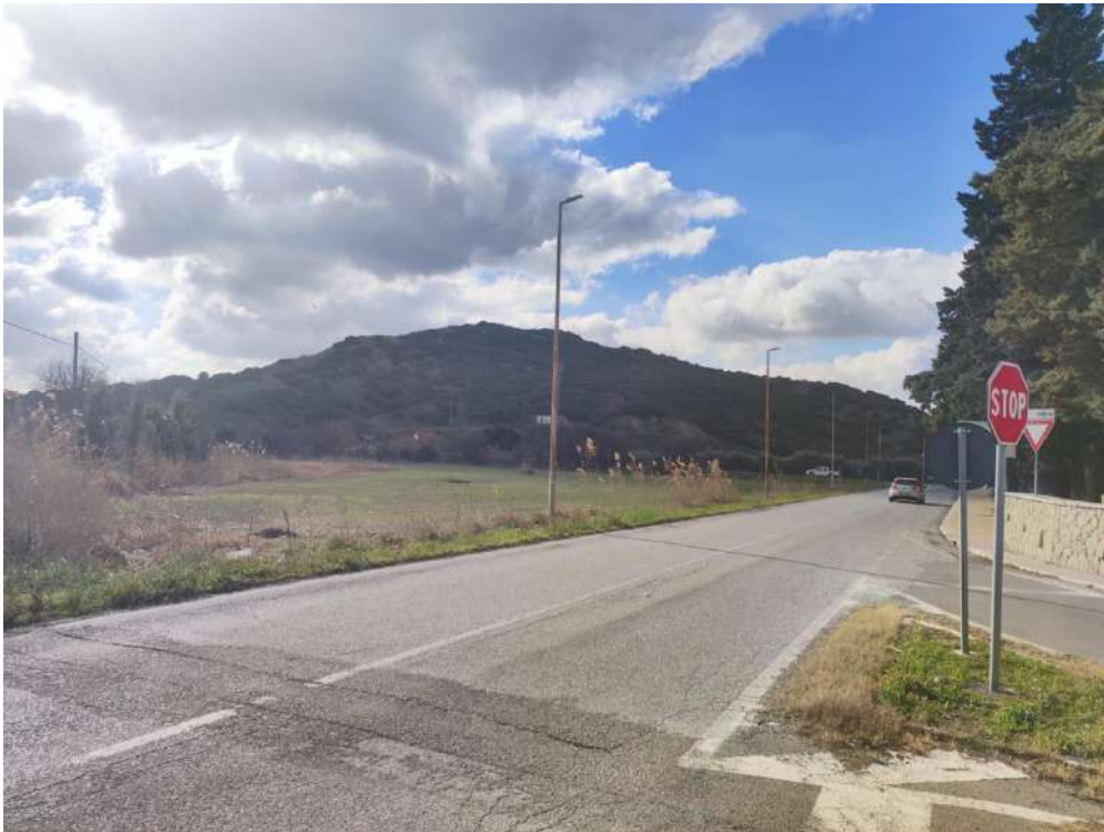
Fig. 26 Punto di presa n.7: Stato di Fatto (SP 176 in prossimità di Craco- Peschiera).
