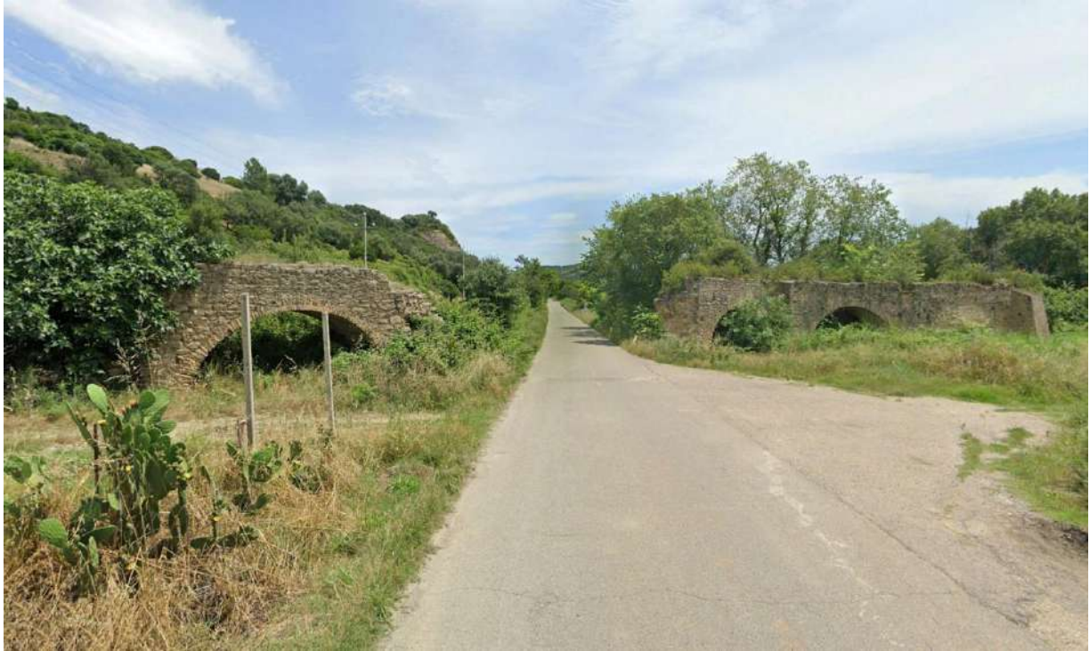
Fig. 75 Punto di presa n. 2: Stato di Fatto (Acquedotto e Mulino Gannano).
