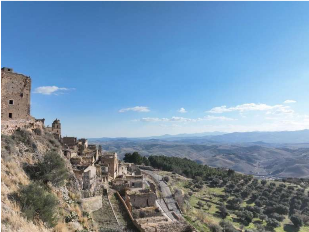
Fig. 38 Punto di presa n. 10.1: Stato di Fatto (Centro storico Craco).
