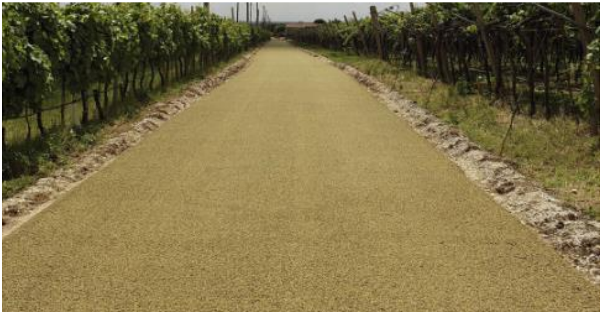
Pavimentazione drenante (tipo ECODRAIN)
