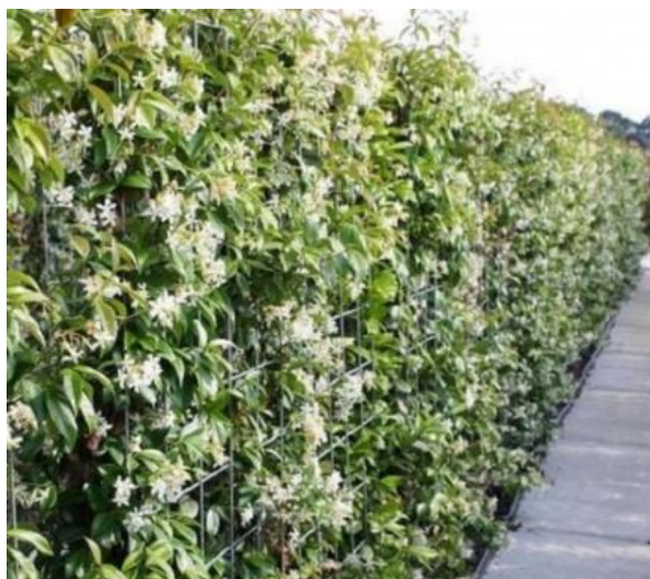
Recinzione in grigliato di acciaio rivestita da piante rampicanti
