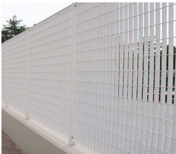
Pannelli in grigliato di acciaio zincati e verniciati a polveri termoplastiche (colore RAL 9010)
