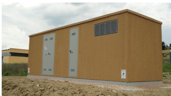
Esempio di cabina prefabbricata in c.a. poggiate su basamento in c.a.
