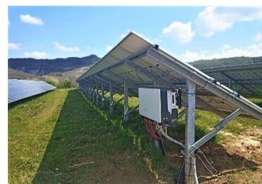
Immagine di esempio del collocamento dell'inverter
