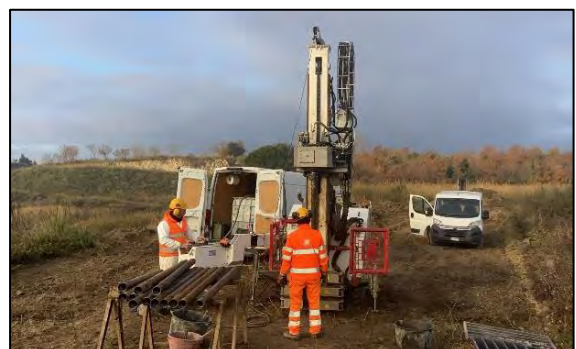
FIGURA 12: ESECUZIONE DEL SONDAGGIO S2
