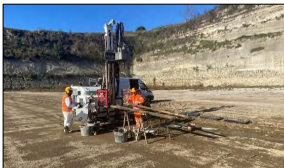
FIGURA 11: ESECUZIONE DEL SONDAGGIO S1
