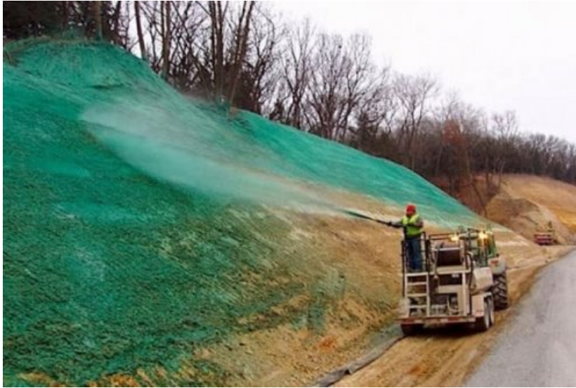
Immagine 10 Immagine esemplificativa della tecnica dell'idrosemina.
