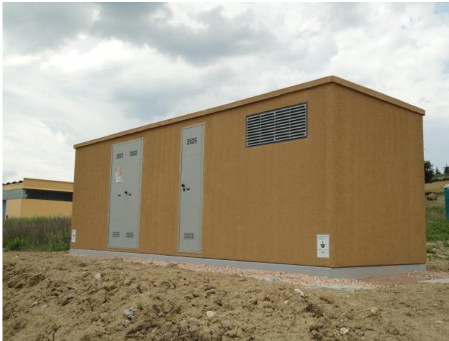
Esempio di cabina prefabbricata in c.a. poggiata su basamento in c.a.
