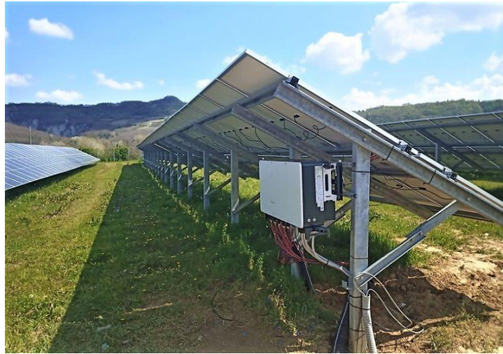
Immagine di esempio del collocamento dell'inverter
