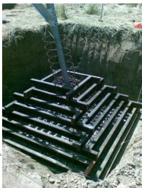
Esempio di realizzazione di una fondazione a plinto con riseghe. Nell'immagine di sinistra di può osservare un disegno di progetto mentre nell'immagine di destra la fase di casseratura della fondazione
