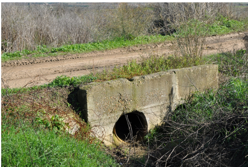
Attraversamento Rio Sassuni lato di valle
