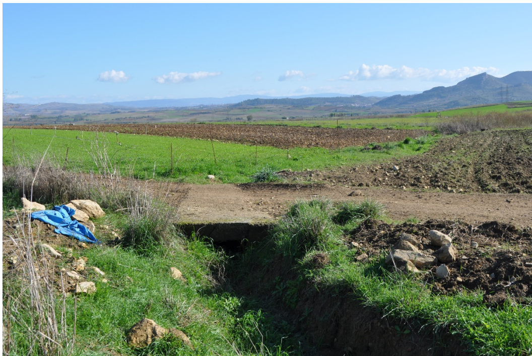
Attraversamento Rio Sassuni lato di monte
