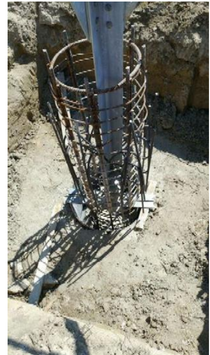
Figura 4.23: Esempio di realizzazione di una fondazione a pali trivellati
