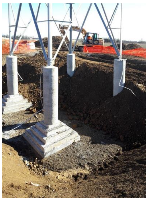
Figura 4.21: Esempio di fondazione di un sostegno
