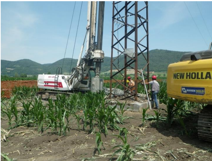
Figura 4.23: Esempio di realizzazione di una fondazione a pali trivellati
