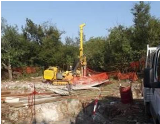
Figura 4.25: Esempio di realizzazione di una fondazione a micropali
