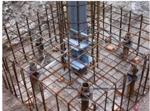
Figura 4.25: Esempio di realizzazione di una fondazione a micropali
