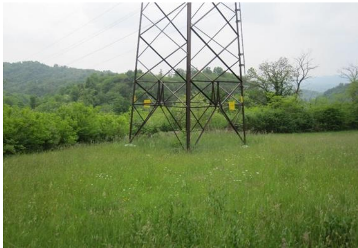
Figura 4.34: Esempio di intervento di inerbimento intorno al sostegno di una linea aerea
