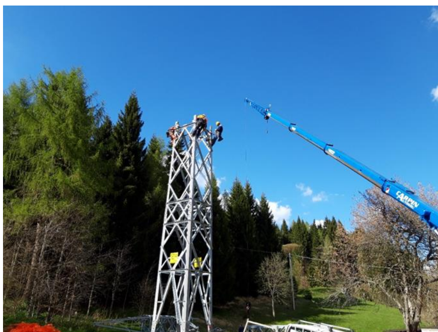
Figura 4.27: Montaggio sostegno con autogrù
