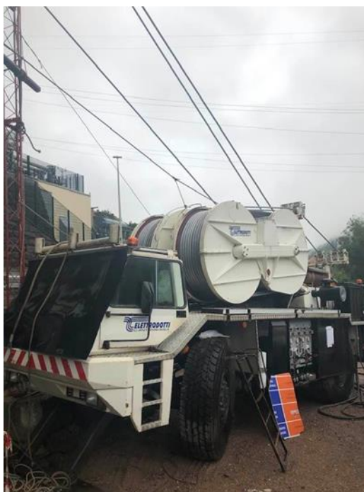
Figura 4.28: Tesatura conduttori
