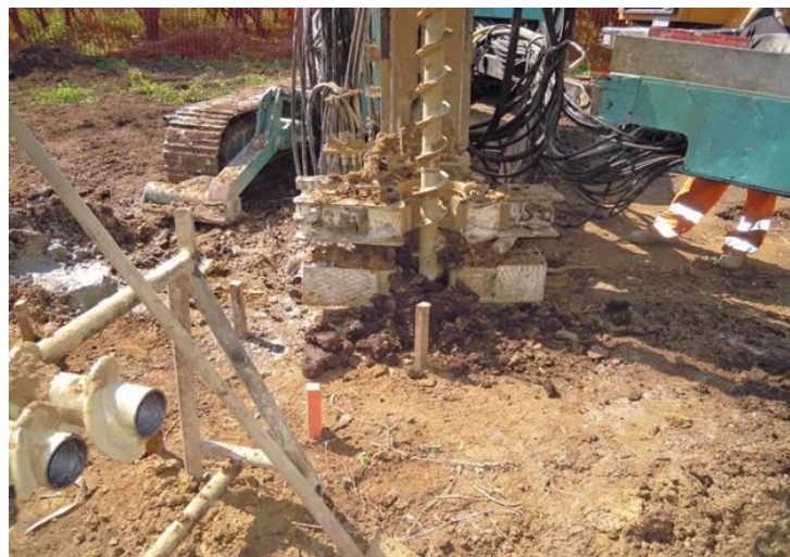
Figura 4.26: Macchina operatrice per la realizzazione di micropali
