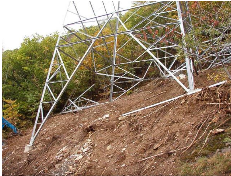
Figura 4.6: Configurazione a quattro piedi dei sostegni
