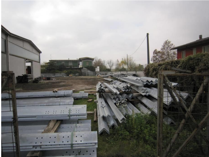
Figura 4.17: Cantiere base – Esempio di deposito materiale
