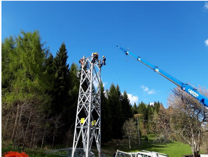
Figura 2.17: Montaggio sostegno con autogrù
