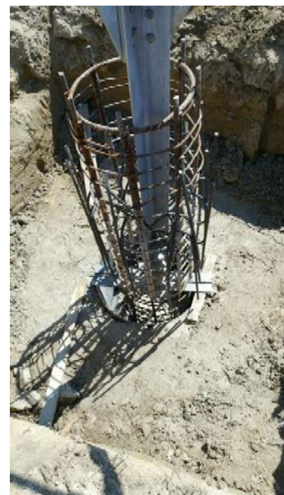
Figura 2.13: Esempio di realizzazione di una fondazione a pali trivellati
