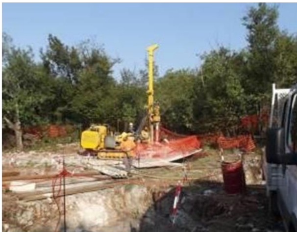
Figura 2.15: Esempio di realizzazione di una fondazione a micropali
