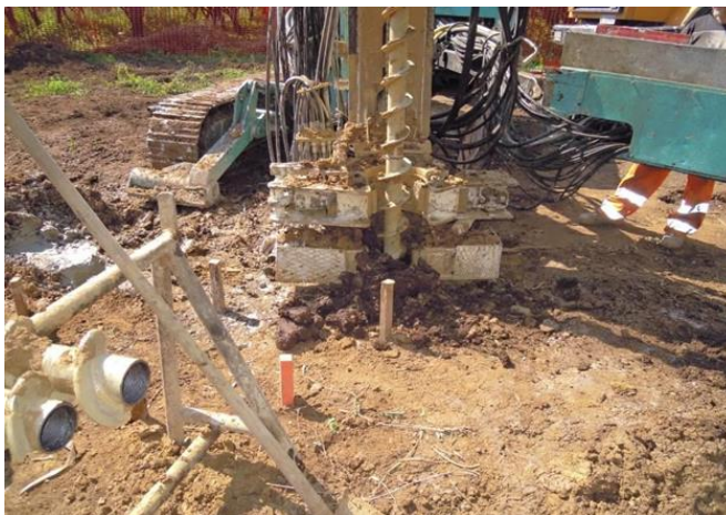
Figura 2.16: Macchina operatrice per la realizzazione di micropali
