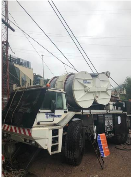
Figura 2.18: Tesatura conduttori
