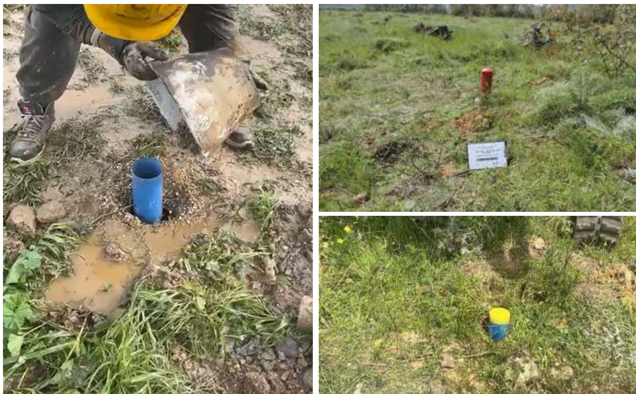
FIGURA 2.6 – A sinistra inserimento di compactionite e a destra la configurazione finale del piezometro.
