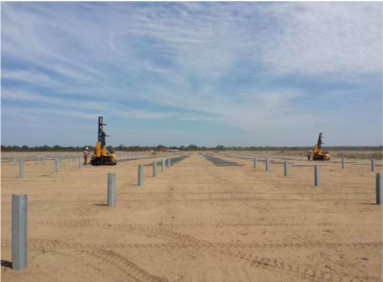
Figura 6.9 – Fase di infissione dei pali con profilo omega (fonte Convert)
