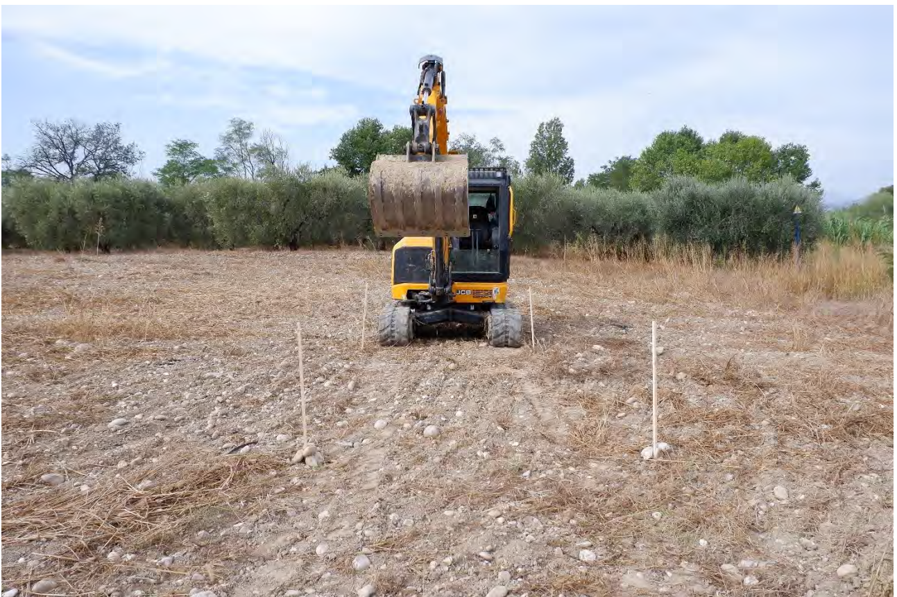
Panoramica e mezzo meccanico sul sito del saggio 8 (18/09/2023)
