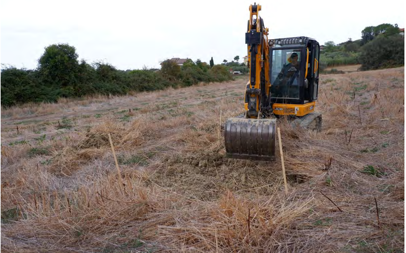
Panoramica e mezzo meccanico sul sito del saggio 14 (21/09/2023)
