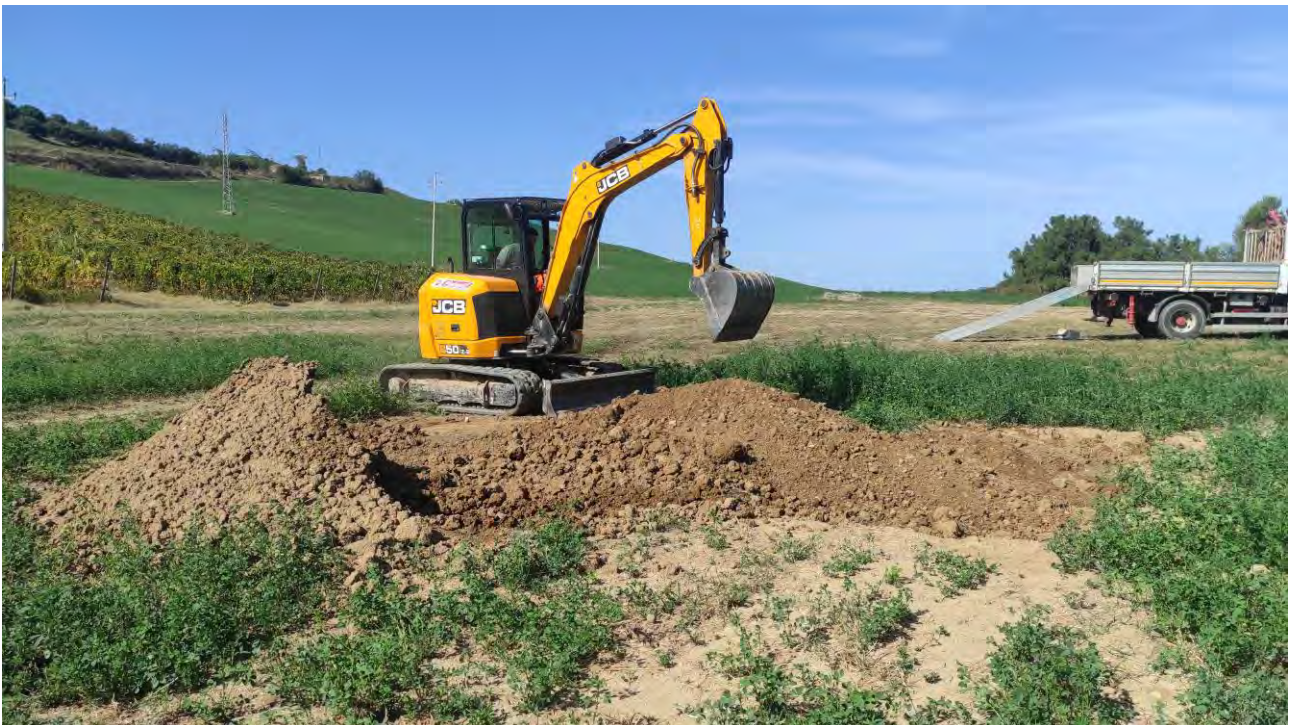
Panoramica e mezzo meccanico sul sito del saggio 23 (10/10/2023)
