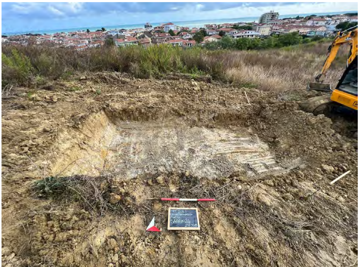
Panoramica e mezzo meccanico sul saggio 24 (25/09/2023)
