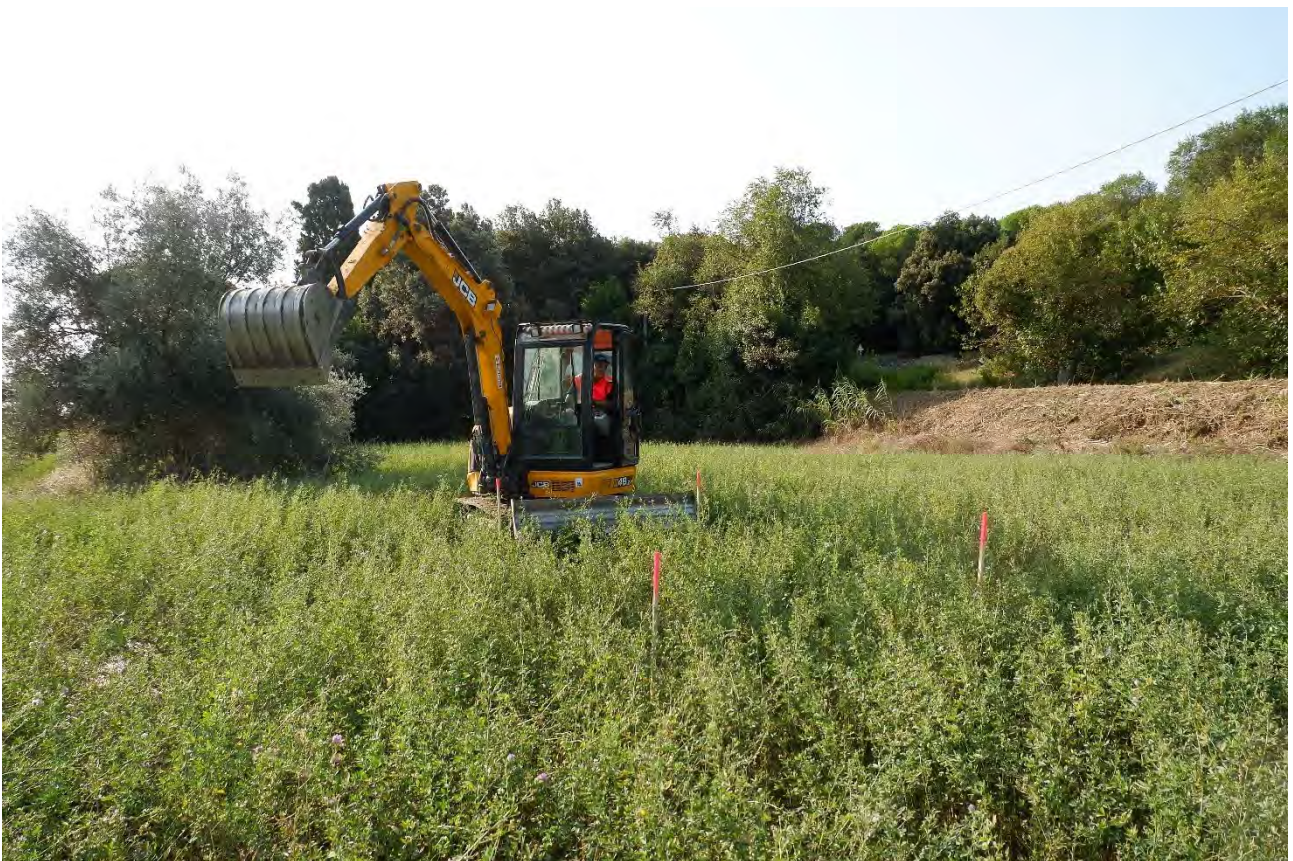
Panoramica e mezzo meccanico sul sito del saggio 26 (26/09/2023)
