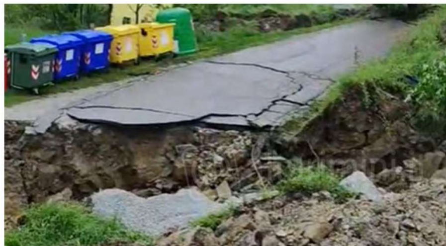
Figura 11 – Immagine di dissesto a causa dell'alluvione del Maggio 2023 che ha colpito la Romagna
