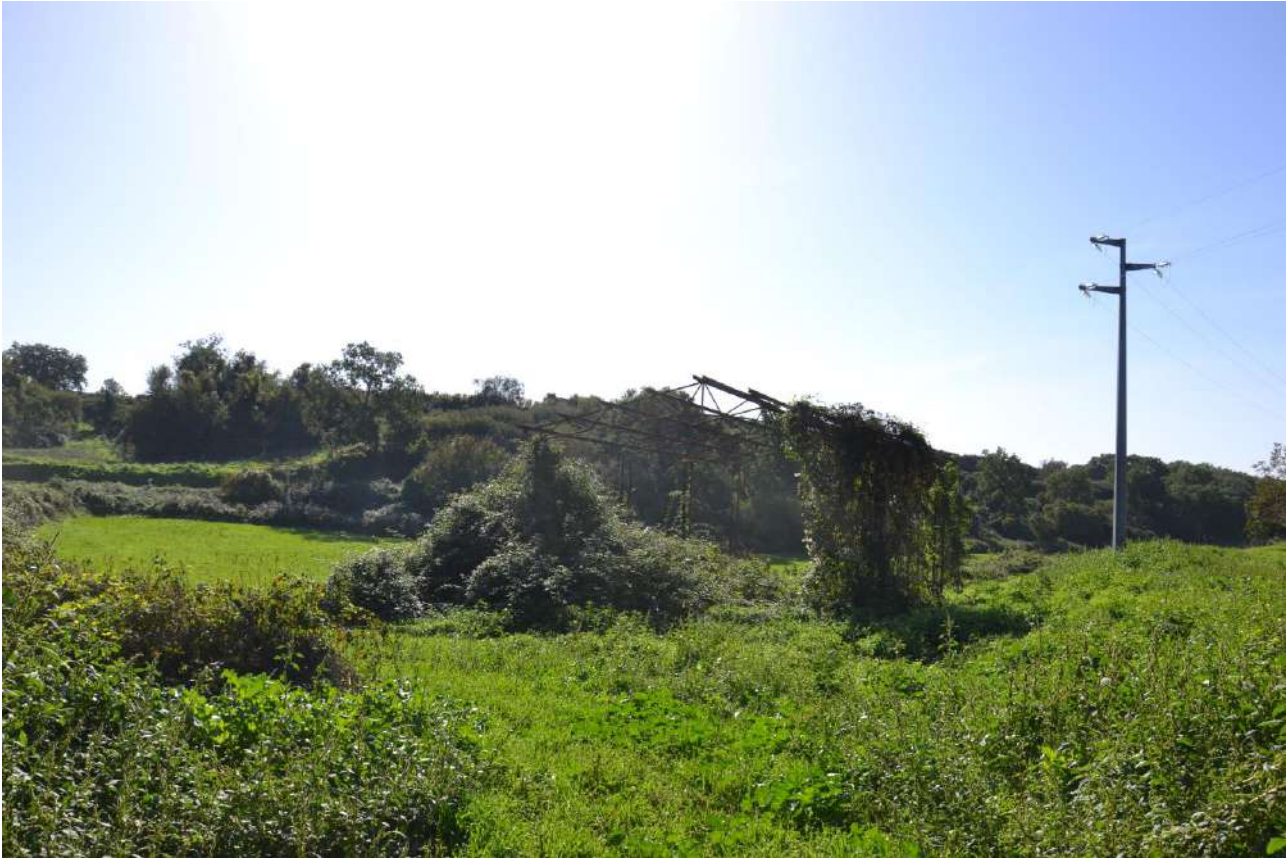
Figura 41. Elementi di degrado nei pressi dell'area d'intervento (esempio)
