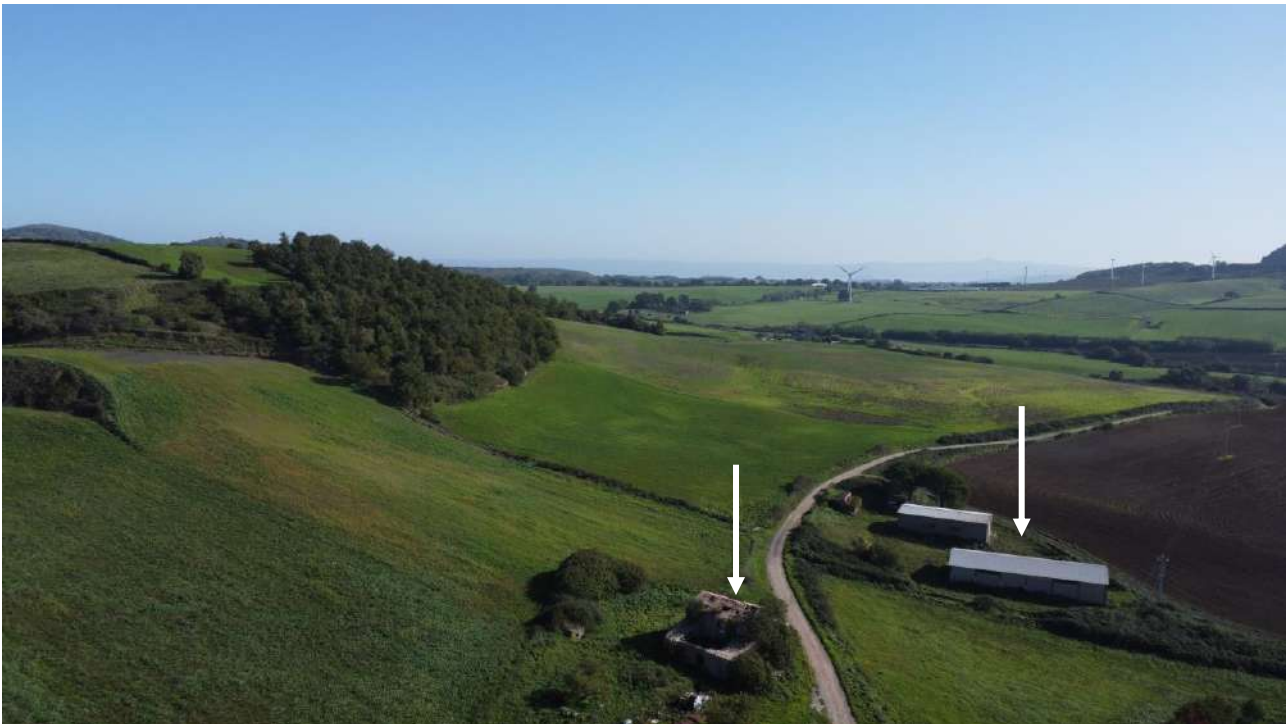
Figura 40. Elementi di degrado nei pressi dell'area d'intervento (esempio)
